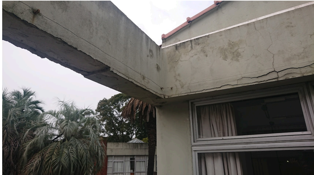
Desprendimiento de revoques
